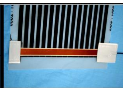
04. 8 Vízhatlan szigetelő tapasz rögzítése a fűtőfilm végek lezárása
