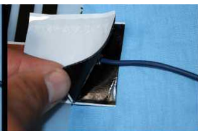
04. 5 Vízhatlan szigetelő tapasz rétegek összeillesztése
