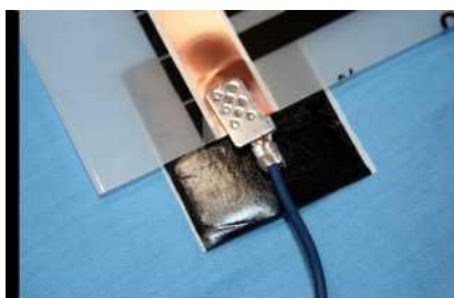
04. 3 Vízhatlan szigetelő tapasz rögzítése alulról
