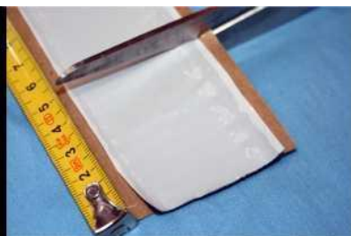
04. 1 Vízhatlan szigetelő tapasz méretre vágása
