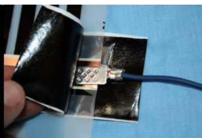
04. 4 Vízhatlan szigetelő tapasz rögzítése felülről
